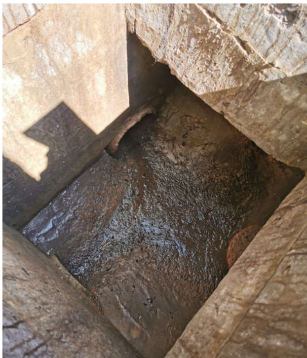
Slika 6 – Priključno kanalizacijsko okno
